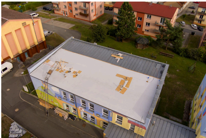
Byla opravena střecha mateřské školy.
