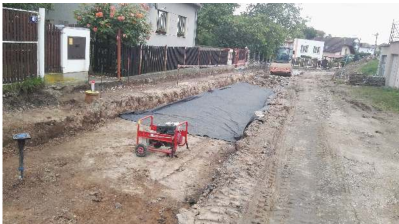
Začala realizace opravy místní komunikace V Rybníčkách
