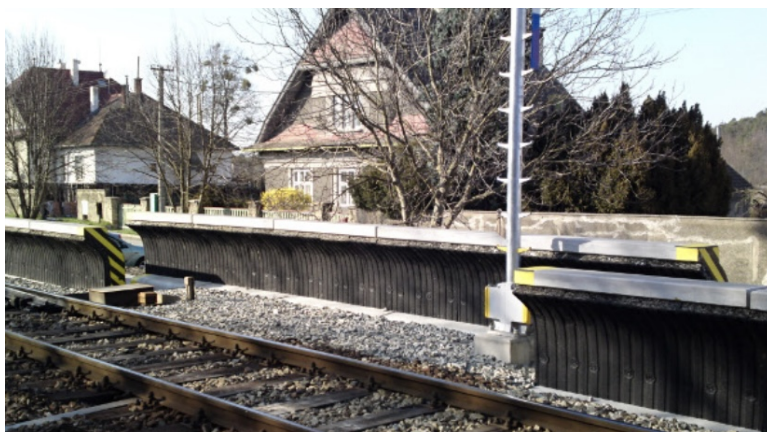
Ilustrační foto protihlukových bariér
