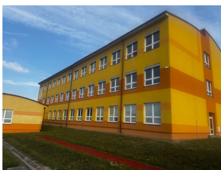
venkovní elektrické žaluzie ve 3. NP ZŠ
