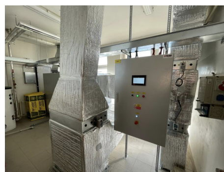
nová vzduchotechnika ve školní jídelně
